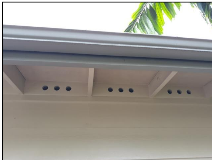
44. Soffit vent
